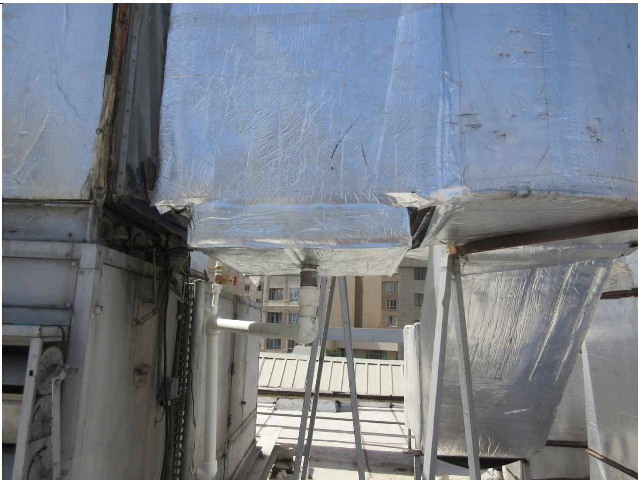
نصب دستگاه پکینگ
